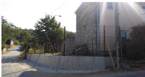
Izrada potpornog zida na Streljani
